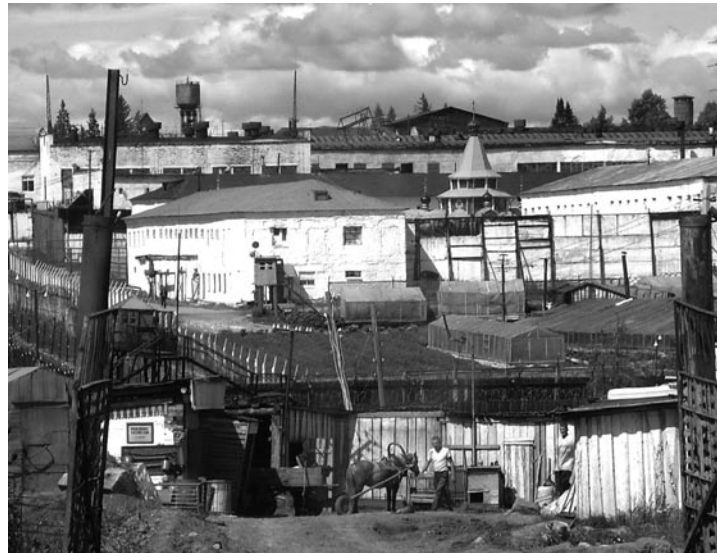
Strafkolonie nahe der Bahnstation Vsevsjatskaja, einige Kilometer von der Strafkolonie IK-35 („Perm-35“) in Central'nyj entfernt.
