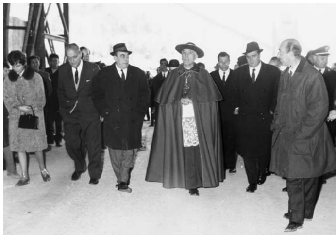
1966, con il cardinale Confalonieri sul cantiere della galleria Monte San Rocco dell'Autostrada Roma-L'Aquila
